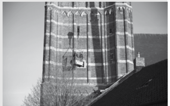
Op weg naar boven voor de inspectie... Foto: Nederweert24
