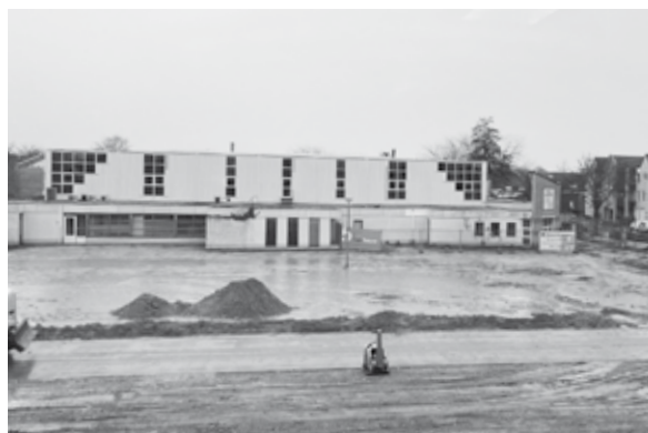
Het oude parkeerterrein is inmiddels verdwenen. Nu vinden er sloopwerkzaamheden plaats bij het achterliggende pand Wijen.
