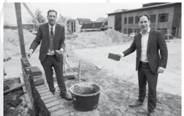
Met het metselen van een muurtje door wethouder Peter Koolen (l) en gedeputeerde Andy Drippy is de bouw van een nieuwe supermarkt en 29 appartementen in het centrum van Nederweert van start gegaan. Foto: Nederweert24
