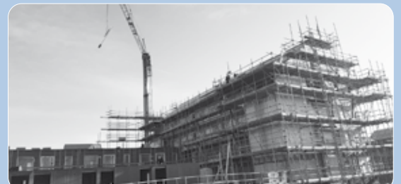
De bouw van de supermarkt en de appartementen vordert. Foto: gemeente Nederweert
