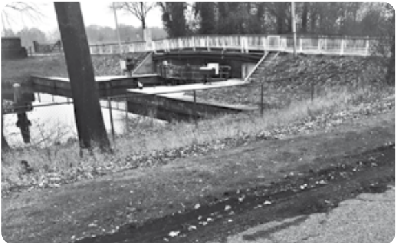
De brug over Sluis Hulslen in de Noordervaart.
