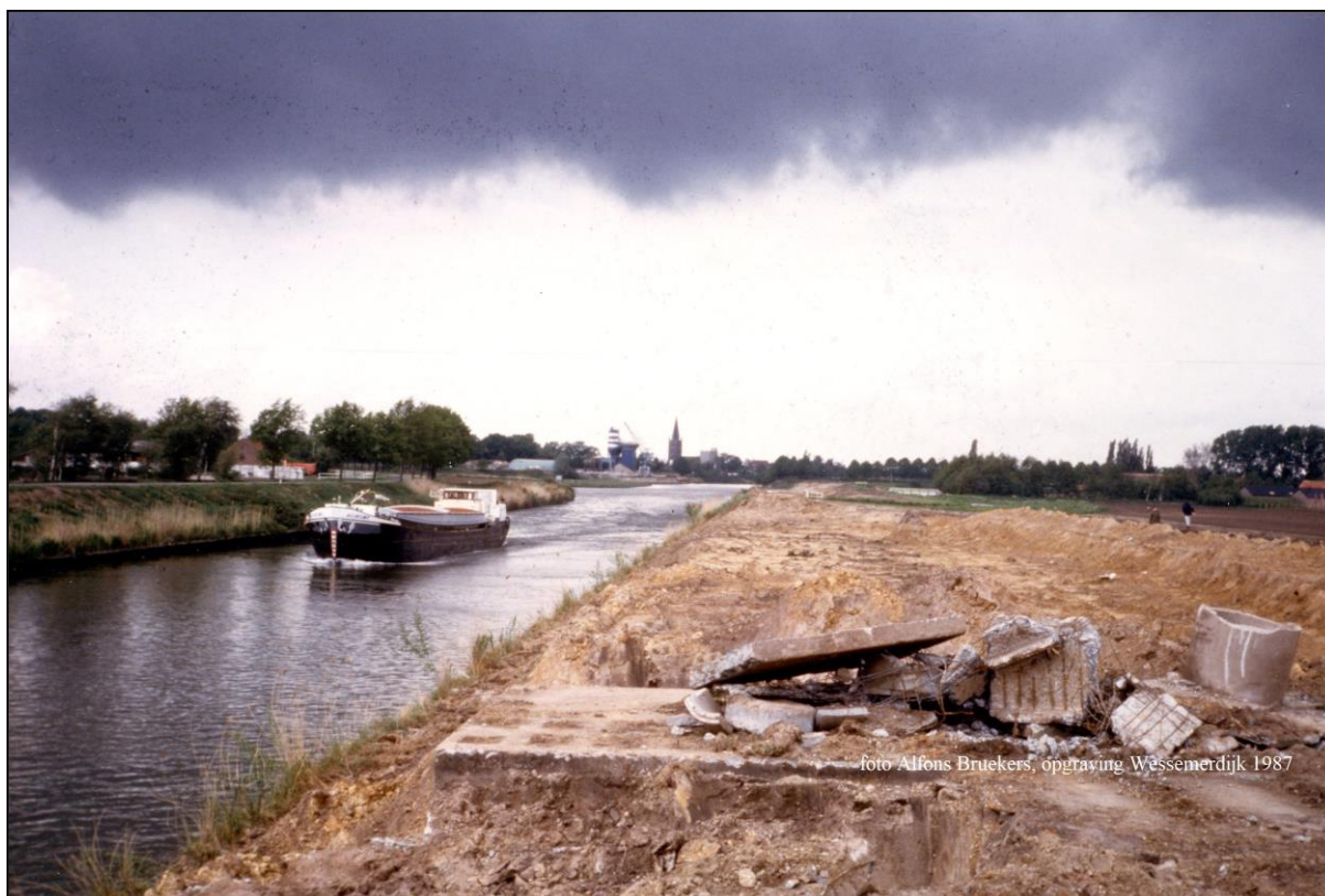
Fig. 3. Beeld van de ontgrondingswerkzaamheden op de oostoever van Kanaal Wessem-Nederweert. Opname ten noorden van de Schoorbrug met op de voorgrond de resten van een 'aspergestelling' van het Nederlandse leger uit 1937.
