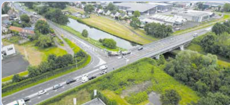
Het fietspad langs de N266 tussen Brug 15 en de nog aan te leggen fietstunnel wordt verbeterd. Foto: Nederweert24
