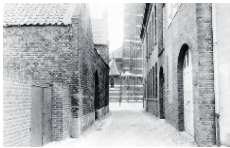
De oude Koolensteeg. Rechts de poort van het gemeentelijke slachthuis, waar de Duitsers hun centrale keuken hadden ingericht. Collectie SGN.
