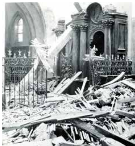
Zware verwoestingen in de noordbeuk van de St. Lambertuskerk, veroorzaakt door neerstortend puin van de kerktoeren. Foto: Jan Biezenaar, collectie SGN.
